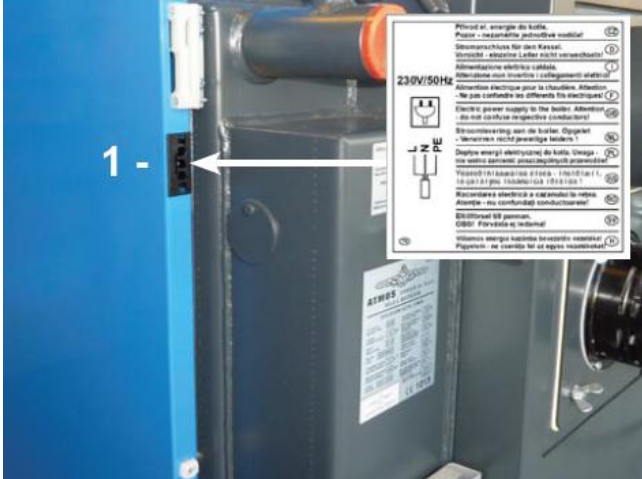
Conectori în partea dreaptă a cazanului
